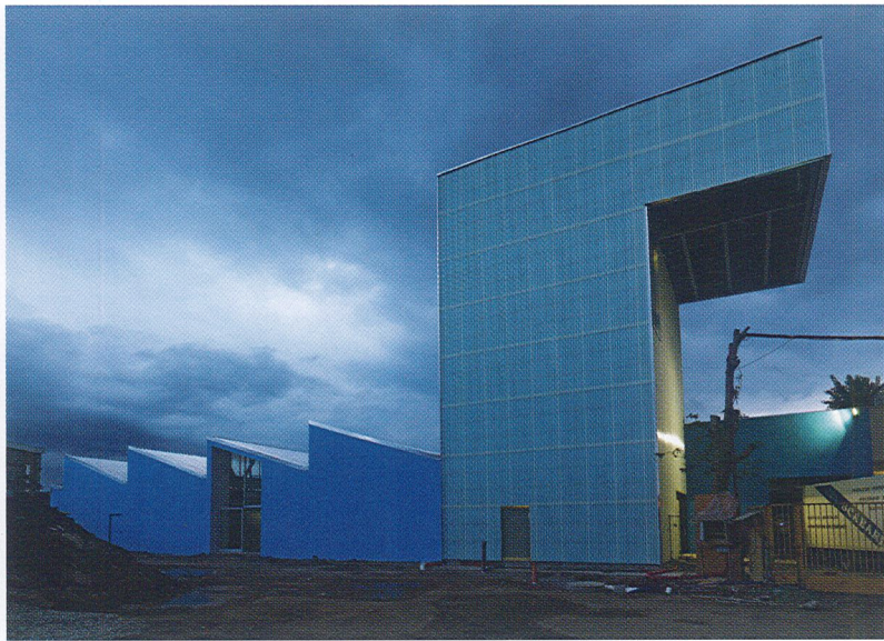
A SINISTRA: VISTA LATERALE DEL LAP. NEL CORPO PRINCIPALE A 'SHED' SONO STATE REALIZZATE DELLE GRANDI APERTURE, SUL CORTILE E SULLA TERRAZZA/PORTICATO CHE SI AFFACCIA SUL LAMBRO. LE APERTURE VETRATE ORIGINALI DEGLI SHED SONO STATE RIMESSE A NUOVO RECUPERANDO IL MECCANISMO DI APERTURA A BASCULANTE ORIGINALE.
